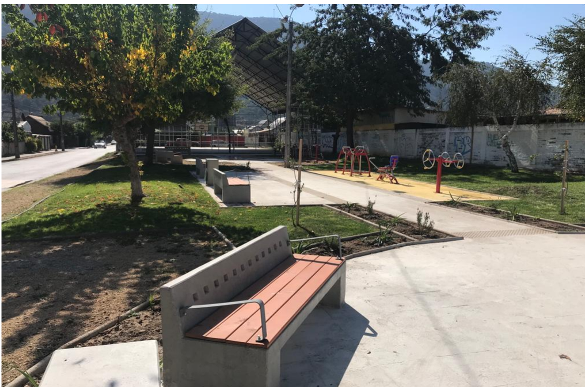
Obras Mejoramiento Áreas Verdes (Villa Rauco)
