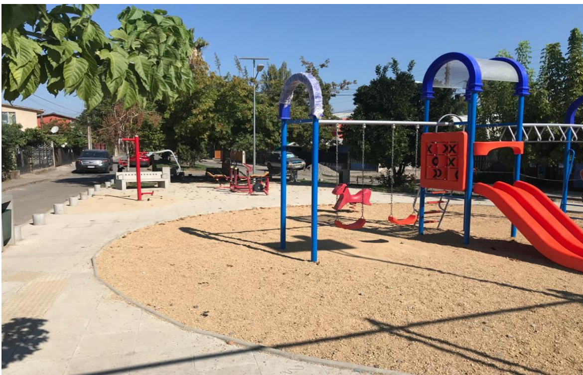
Obras Mejoramiento Áreas Verdes (El Dorado)
