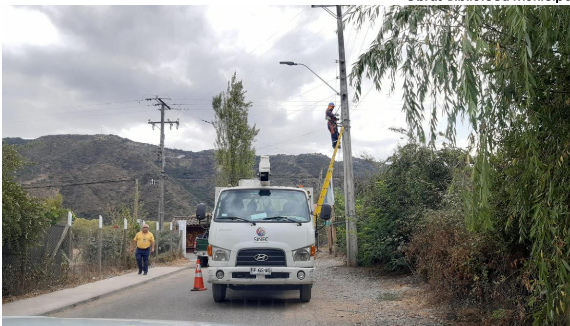
Obras Cambio de Luminarias
