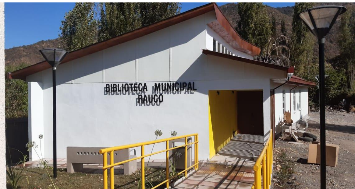
Obras Biblioteca Municipal
